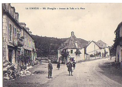
Sur la gauche, la route pour Lagarde, ancienne route de Rodez à Limoges. Sur la droite, la route de Tulle, nouvelle route de Rodez à Limoges.
